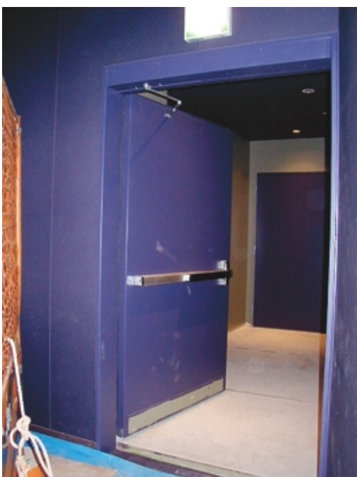
FD-50：ユニバーサルスタジオジャパン ターミネーター2 パニックバー：VD98L(電気ラッチ式) 空圧式パワーオープンドアローザー
