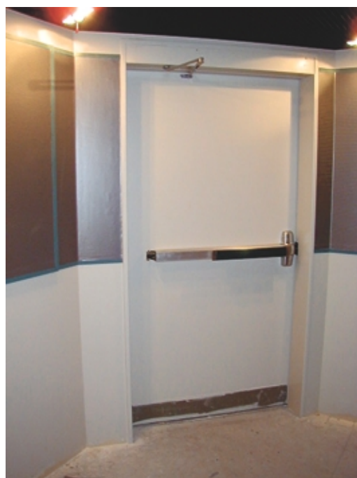
FD-50：ユニバーサルスタジオジャパン バックトゥザフューチャー パニックバー：VD98L(電気ラッチ式) 空圧式パワーオープンドアローザー
