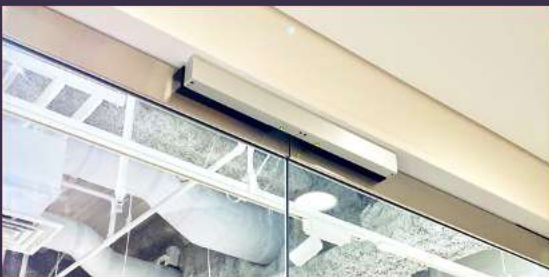
世界標準の「停電時解錠型」マグネット式電気錠
