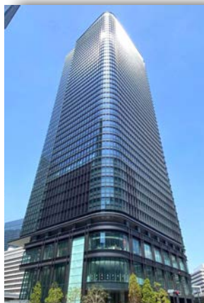
常盤橋タワー
