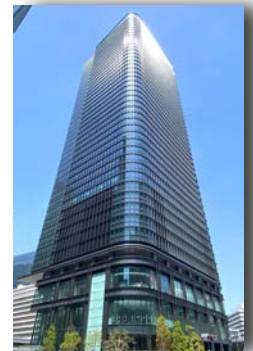
常盤橋タワー
