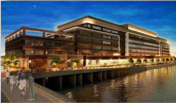
横浜地方合同庁舎
